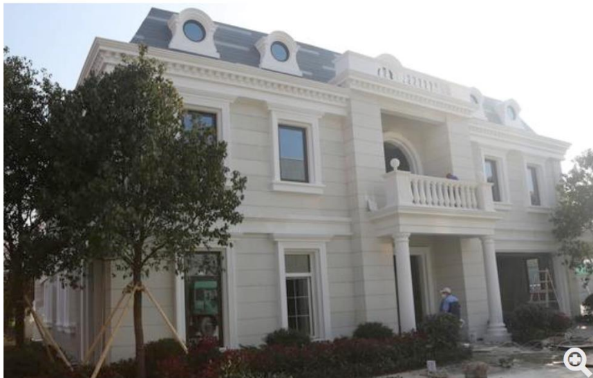
Diese 1100 Quadratmeter große Villa besteht aus Bauteilen aus dem 3D-Drucker. Kostenpunkt: 161.000 US-Dollar.
